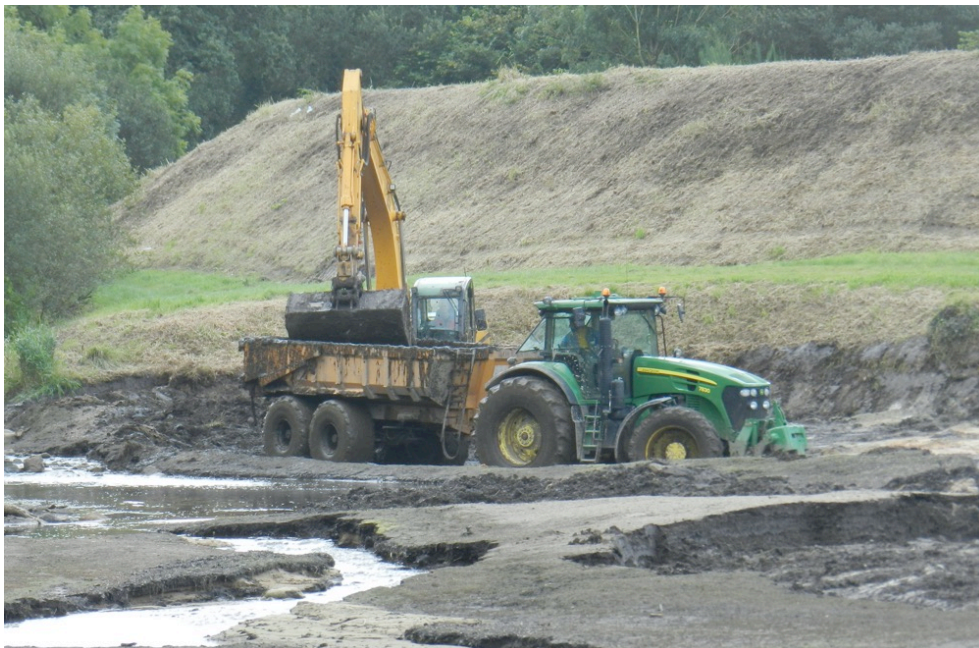
Figure 23 : Pelle avec tracteur agricole avec benne lors du curage de 2012 (source Syndicat)
