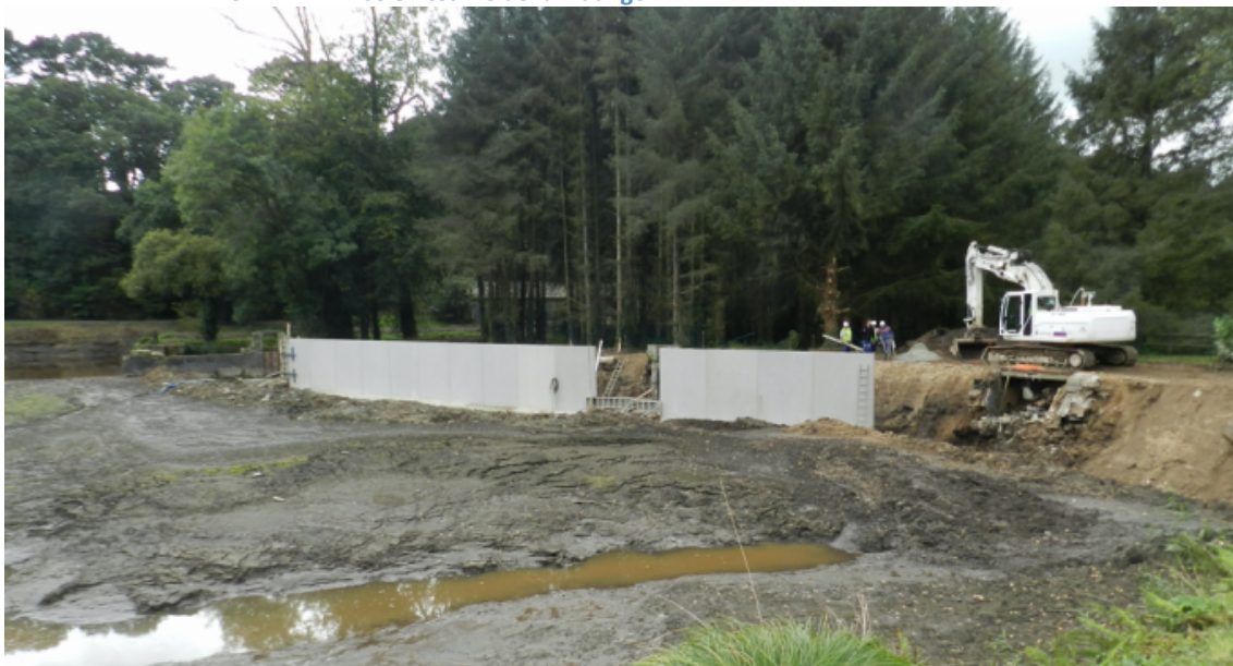
Figure 20 : Travaux de confortement de la digue de Moulin Neuf en 2010 (source Syndicat)
