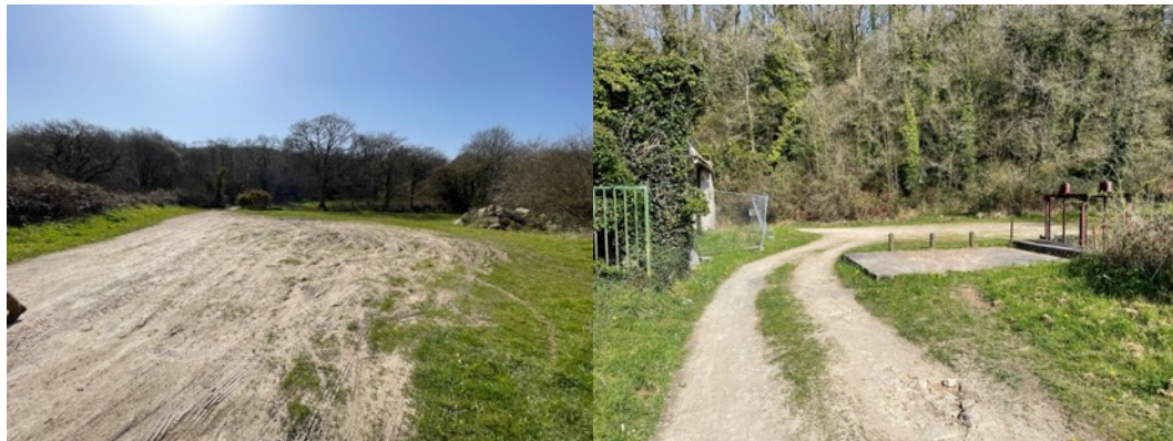
Figure 35 : Terre-plein du Moulin de Carman à renforcer et franchissement de la vanne du Moulin
