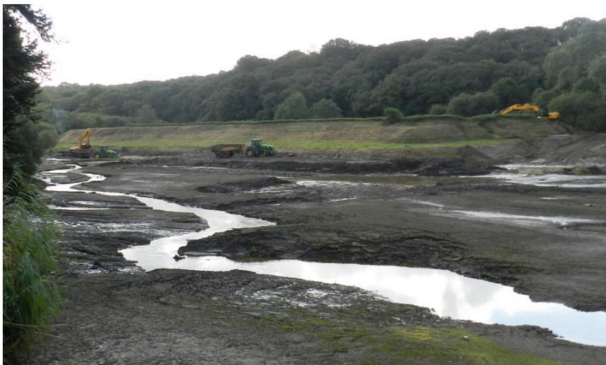
Figure 26 : Vue des travaux de curage de 2012. On aperçoit le lit original de la rivière au premier plan (source syndicat)
