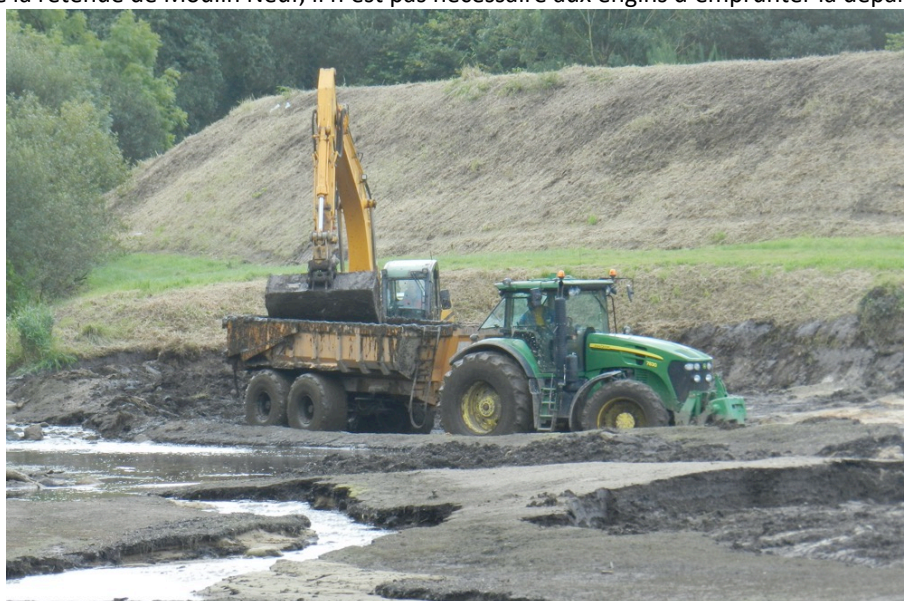
Figure 70 : Pelle avec tracteur agricole avec benne lors du curage de 2012 (source Syndicat)
