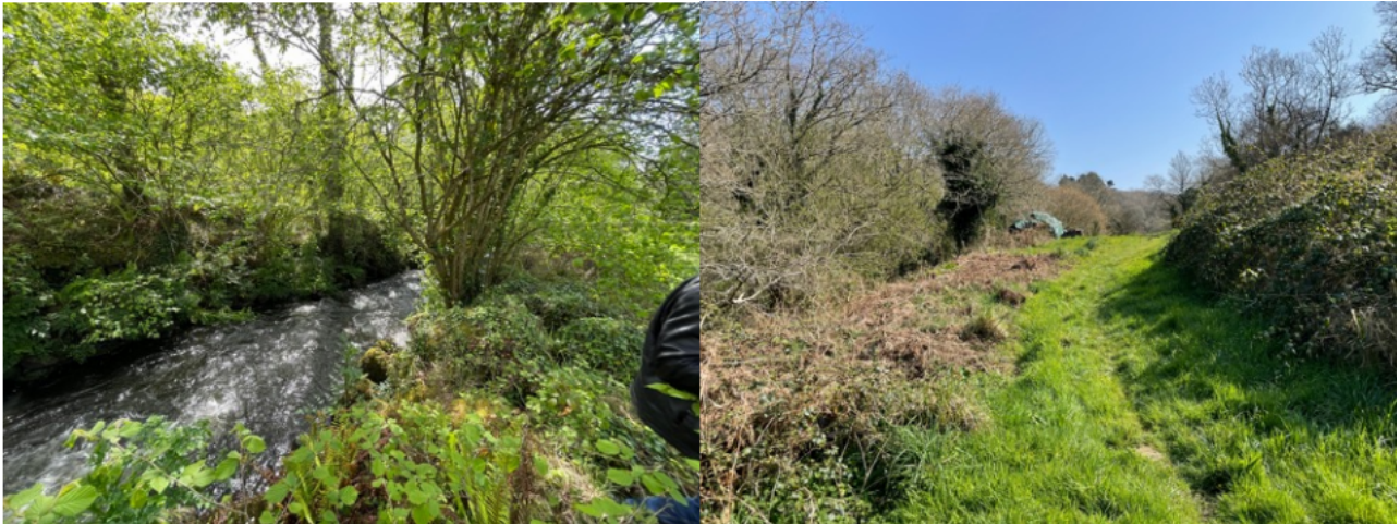
Figure 7 : À gauche, zone du franchissement à créer, à droite piste à renforcer
