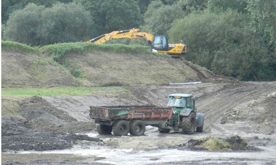
Figure 24 : Convoi empruntant le plan incliné vers la lagune de ressuyage durant les travaux de 2012 (source Syndicat)
