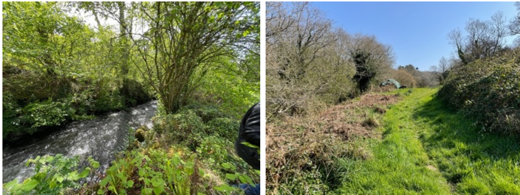
Figure 34 : À gauche, zone du franchissement à créer, à droite piste à renforcer
